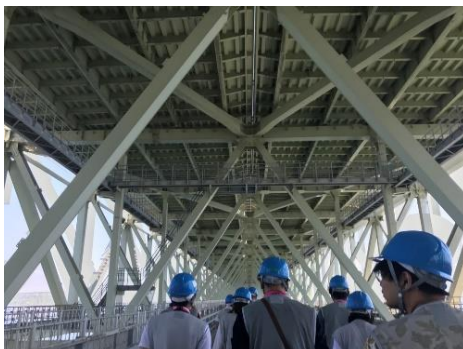
明石海峡大橋の見学
